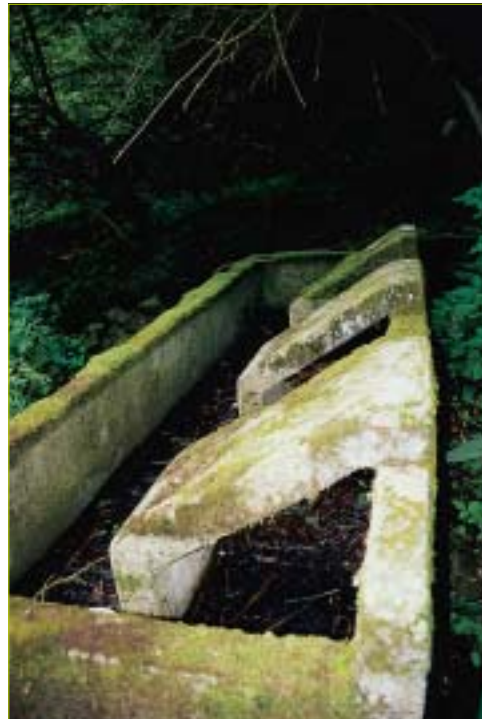
Perišče zahodno od Mohorjevega mlina. Laundry spot west of Mohorjev mill.
